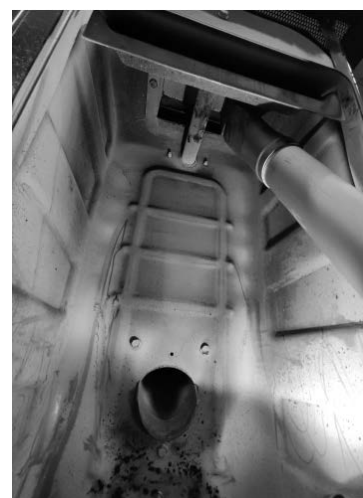
Fig. 71 - Die Asche absaugen
